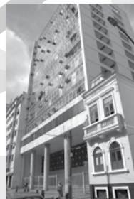
Figura 8. Prédio da Rua dos Inválidos
